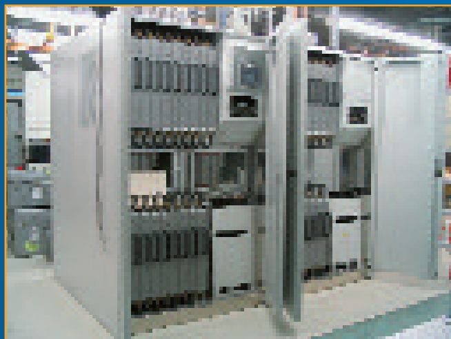
▲ Nouvel émetteur Thalès de 40 Kw à la station CIVM de Montréal
